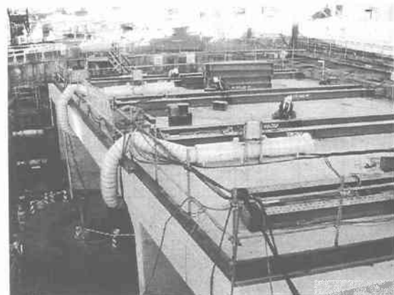
写真-1 F C プレート固定工全景
