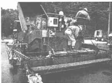
写真-1 厚層舗設工法用アスファルトフィニッシャー
