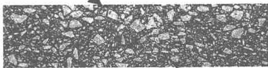
写真-4 ジョイントの断面状況の例
