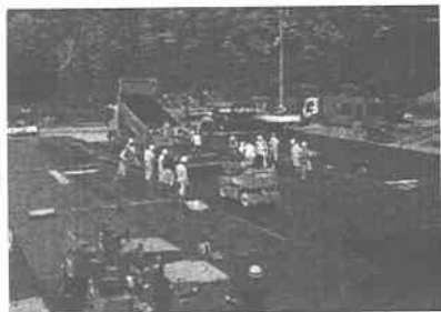
写真-2 舗設試験Ⅱヤード全景
