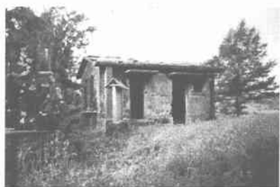
写真3 石垣島旧沖縄台湾間通信施設
