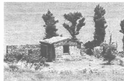
写真1 東シナ海岸に面した石垣島 旧沖縄台湾間通信施設 (写真提供石垣市教育委員会)
