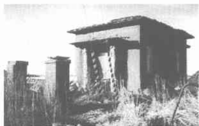
写真2 根室旧北方領土通信施設 (写真提供石垣市教育委員会)
