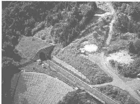
図-1 (出口付近写真)
