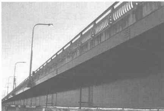
写真-6 地覆側面状況
