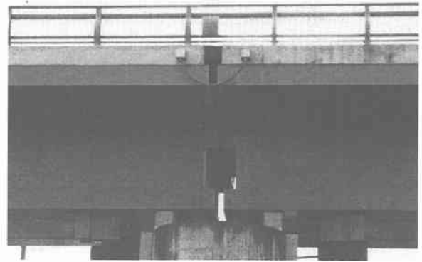
写真-5 地覆側面状況
