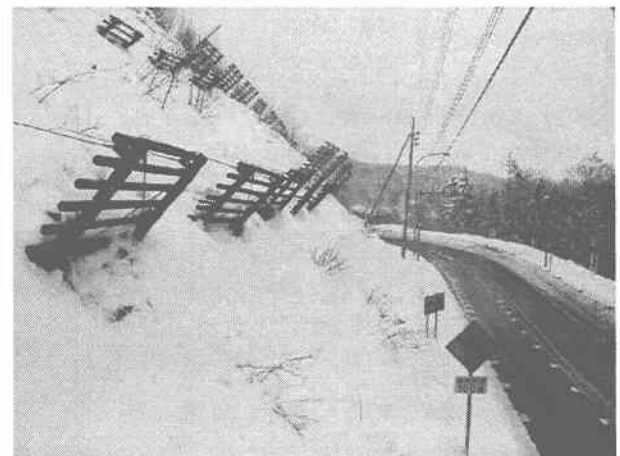
写真-4 雪崩管理におけるカメラ画像
