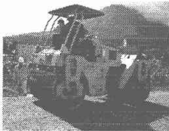
写真－2 転圧状況
