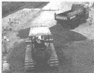
写真－1 敷き均し状況
