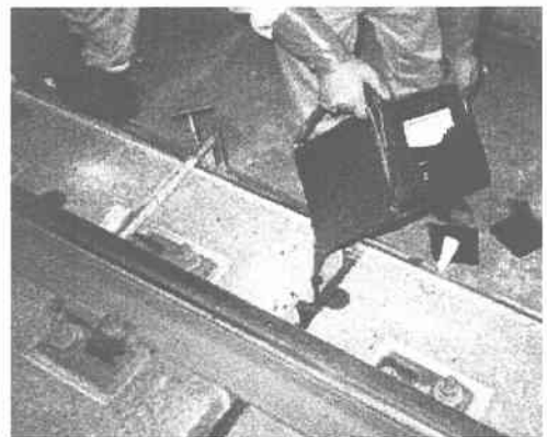
図2 CA モルタルの修繕作業
