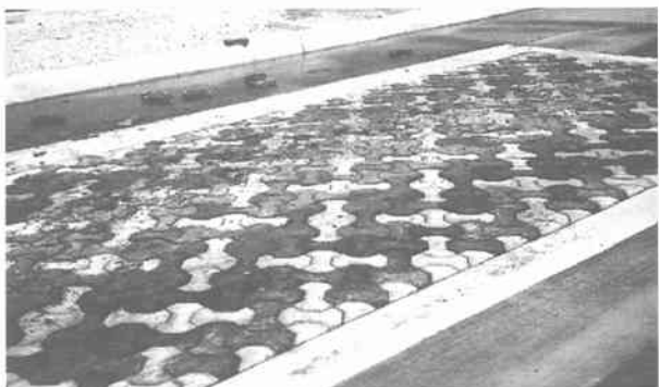
図-8 グレーダー走行後の状況
