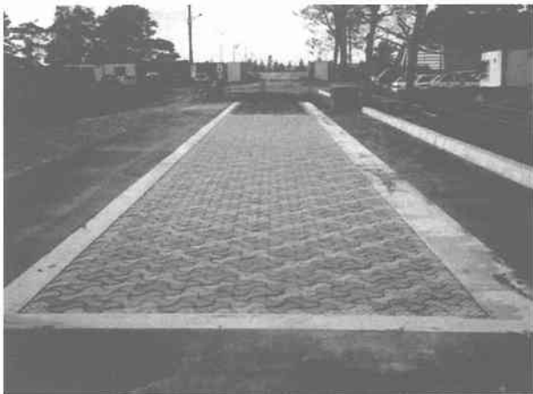
図-6 弾性舗装の外観
