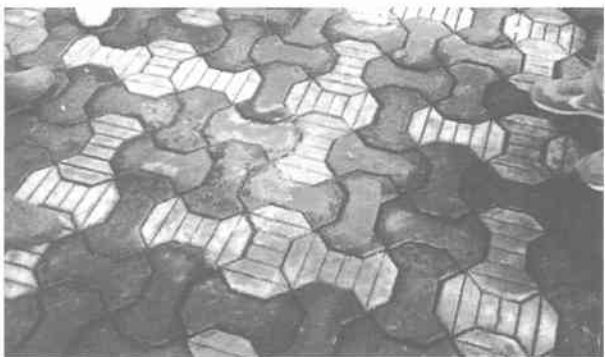
図-9 ドーザー走行後の状況
