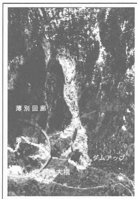
写真-1 崩壊地全景写真 (H12/5/15撮影)
