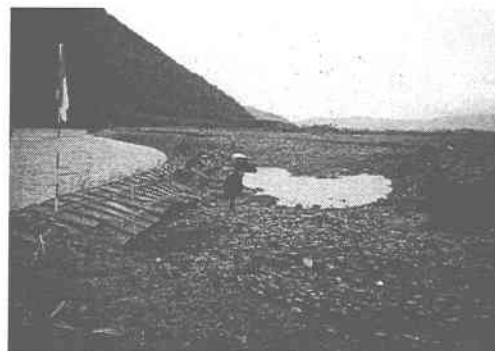
写真-1 洪水時に形成された砂州による深掘(16kp)
