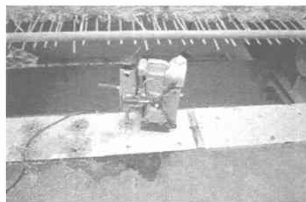
写真-6 フィラープレートを利用した主桁削孔
