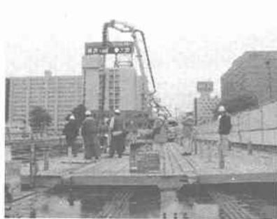
写真-9 高流動コンクリート打設
