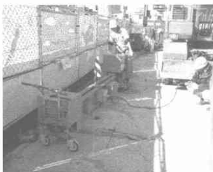
写真-5 ジャッキビームによる既設床版撤去
