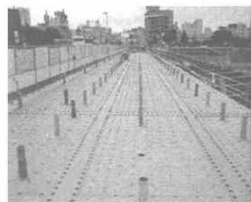
写真-8 床版架設完了
