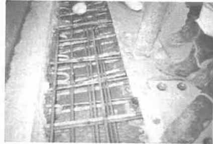
写真-4 1期施工と3期施工の継手部
