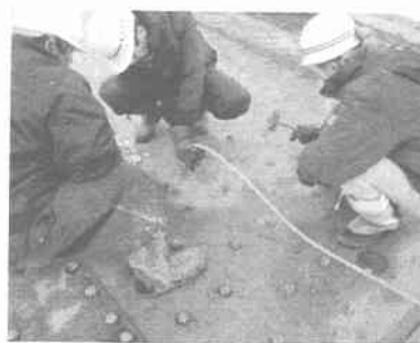
写真-12 注入による空隙確認
