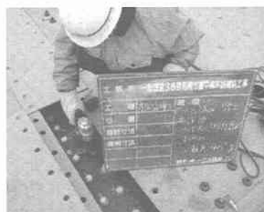
写真-7 上面からのボルト締付け
