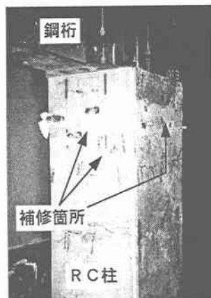
写真－1 補修状況
