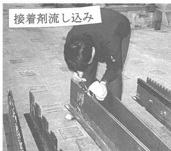
写真1：両添接板の間に接着剤流し込み
