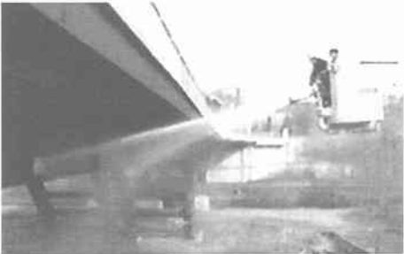
写真-1 米国における橋梁洗浄の状況 (AISIの資料より)
