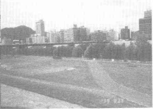
写真一七 平成11年3月伐採から (平成11年8月撮影) 5ヶ月後
