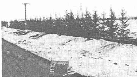
写真 1 狭林帯防雪林の設置状況
