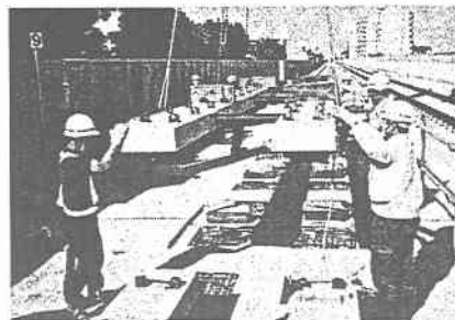
写真-2 ラダーマクラギ架設状況
