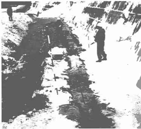
写真-4 雪塊閉塞状況
