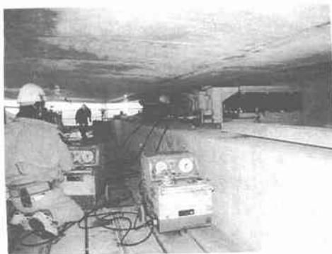
写真-1 ジャッキおよび治具設置状況
