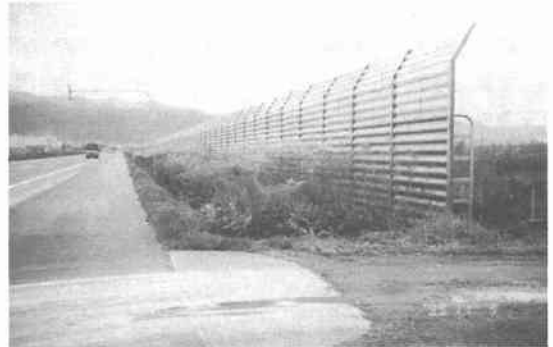
写真-1 現場風景
