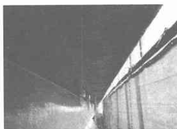
施工前（張出床版下面）
