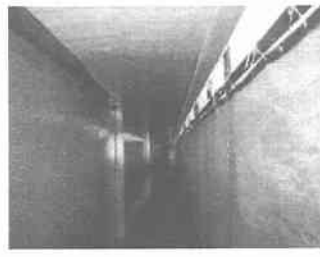
断面復旧，コンクリート保護完了
