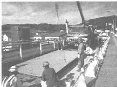
写真－３ 上鋼板取付状況
