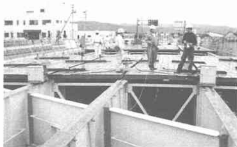
写真-4 搬送装置による版の移動
