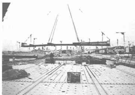
写真-5 架設状況
