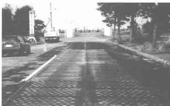
写真2 試験舗装外観
