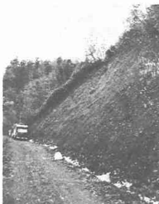
図 8 ケーブルを敷設した斜面
