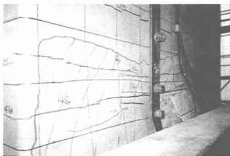
写真—1 S55A3 供試体実験終了後の柱基部破壊性状
