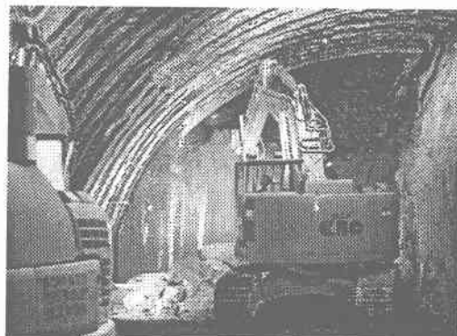
写真－１ 後進坑掘削状況
