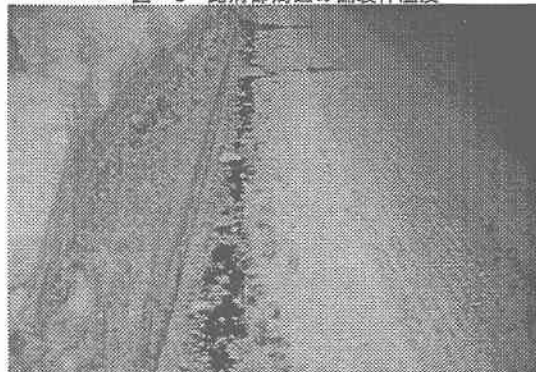
写真-3 埋設されている電熱線により筋状に雪氷が融解している
