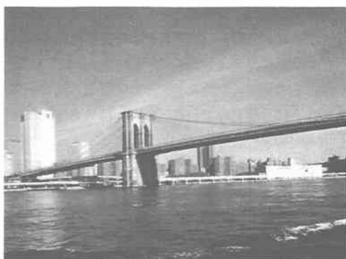
写真—2 ブルックリン橋
