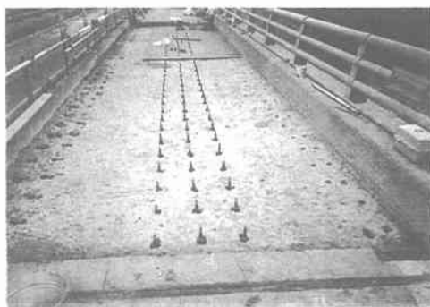
写真-2 ボルト取付、上鋼板取付状況
