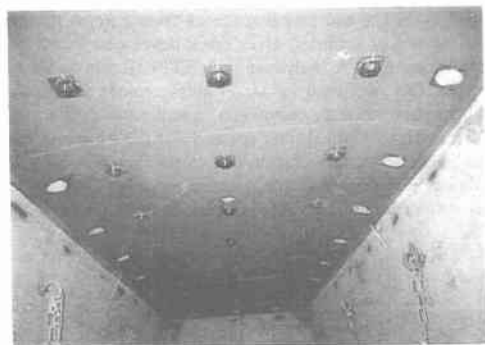
写真-3 下鋼板取付完了
