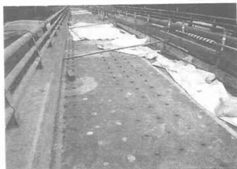
写真-4 上鋼板取付・注入完了
