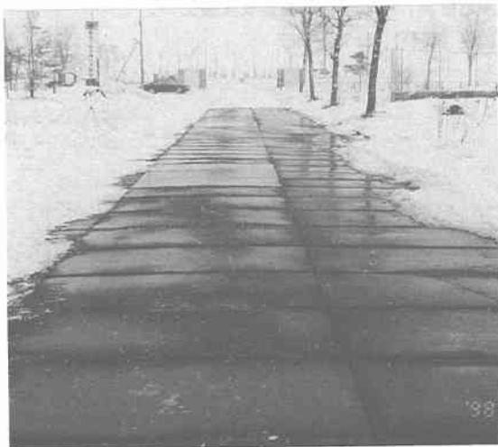
写真1 ゴムチップ板試験舗装の概観
