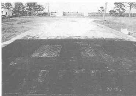
写真-4 制動試験状況
