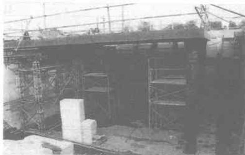
写真-1 サンドイッチ覆道（実物大供試体）
