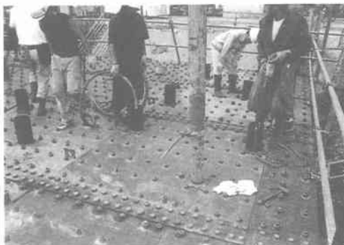
写真-3 高流動コンクリート打設状況
