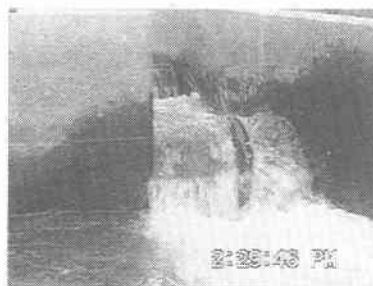
パターン③-1. 隔壁落水部下流側から跳躍し、
