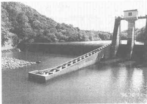
写真-1 蘭越発電所魚道の全景
