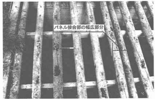
写真4 ディアガードパネル接合部
