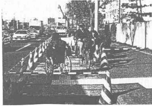
写真－4 デッキ走行調査 及び本線車両への影響調査
