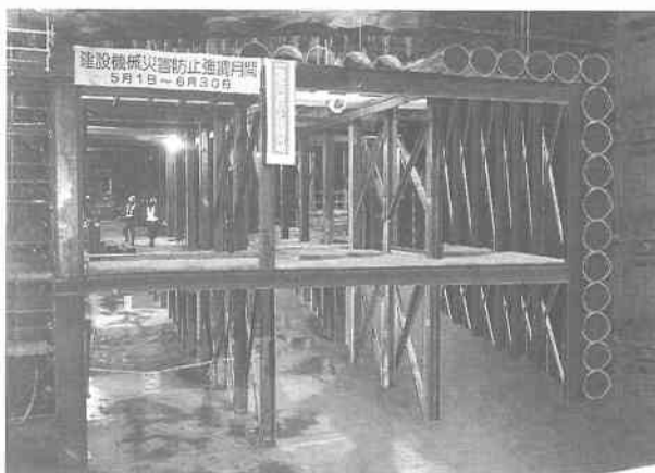
写真－1 支保工兼用による中段作業床
