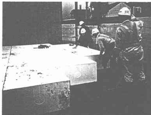
写真－２ EPS 積み込み状況
