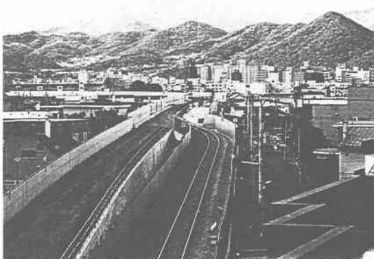
写真-1 開業後の補強盛土
