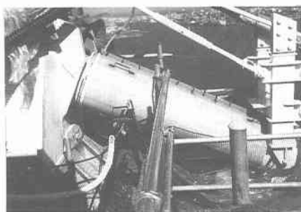
写真－４ 型枠設置・ポリウレタン注入状況
