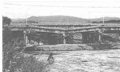
写真-3 復旧対策工
