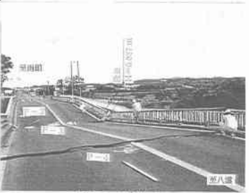
写真-2 橋面状況
