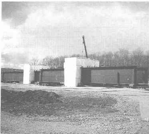
写真－１ 風防設備
