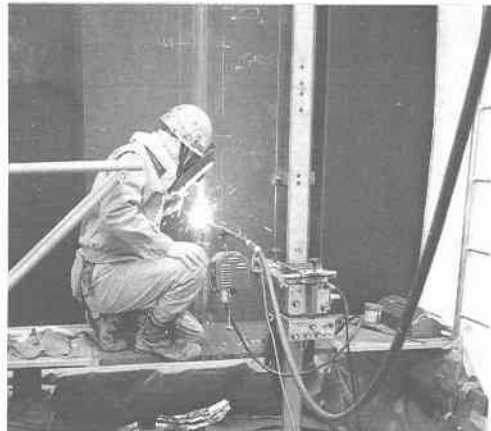
写真－２ ウェブの溶接状況
