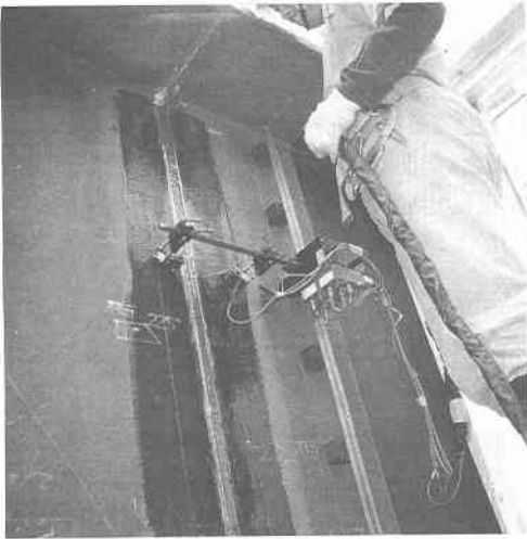
写真－3 AUT検査状況
