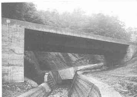
写真-1 小鈴岸川橋完成写真
