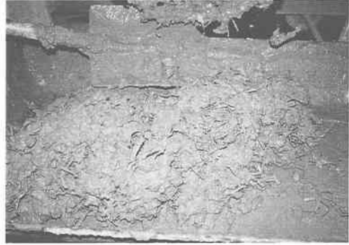
図-2 コンクリート練混ぜ状況
