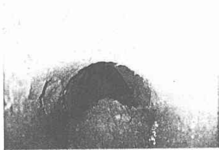
写真-2 350kN載荷後数分後の大崩落 天端部が崩落しズリが坑内を埋める。
