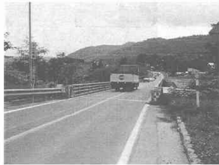
写真-2 橋梁の例
