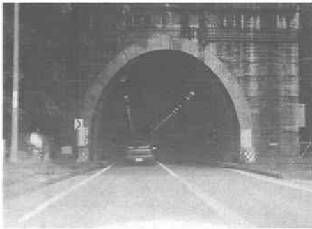
写真-1 トンネル出入り口の例
