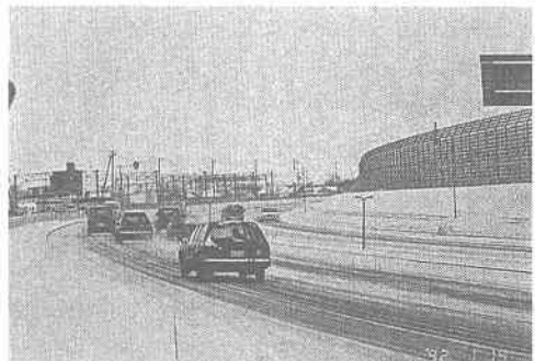
図-3道路構造の変化点(切土と盛土の境)で急減している吹雪時の視程
