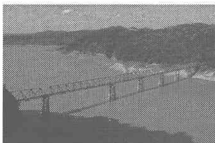
写真1 シューパロ湖上の三弦トラス橋の全景 (1994年9月撮影)
