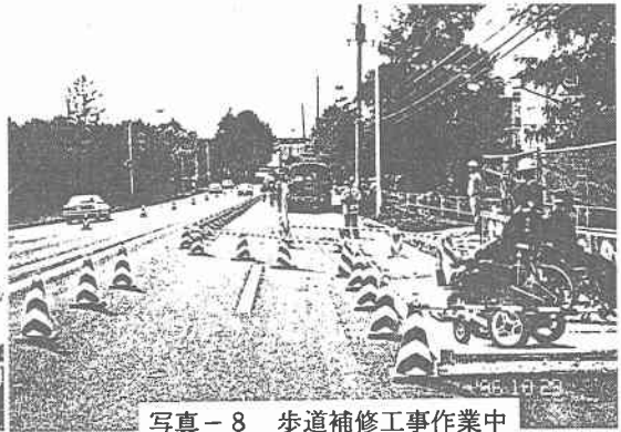
写真-8 歩道補修工事業中
