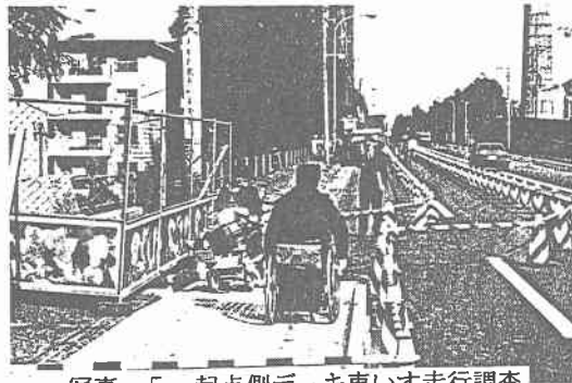
写真-5 起点側デッキ車いす走行調査
